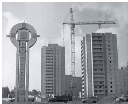
Строительство Суздальского проспекта на въезде со стороны Суздаля
