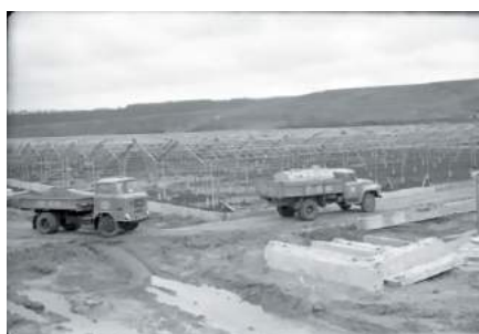
Начало строительства совхоза «Тепличный» в восточном районе
